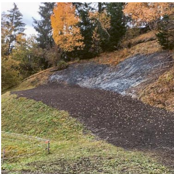
Einer der sanierten Kugelfänge.
