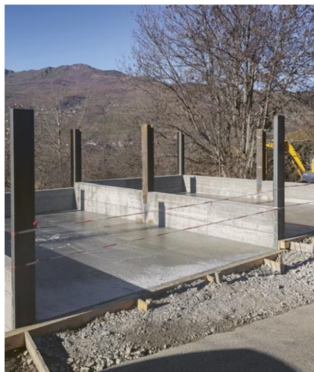
Bau der Grüngutsammelstelle in Duvin.
