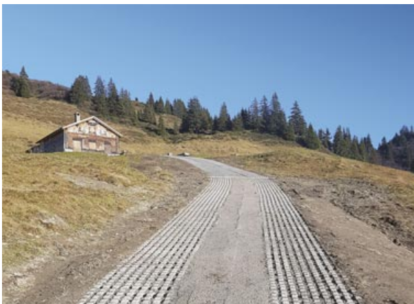
Die sanierte Zufahrt zur Alp da Schnaus.
