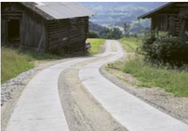
Die Güterstrasse bei Gliandaus in Siat wurde mit Betonspuren versehen.
