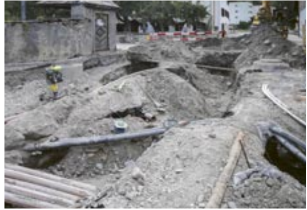
Für das Ersetzen der Werkleitungen an der Porta Sura in Illanz musste die Strasse für längere Zeit gesperrt werden.
