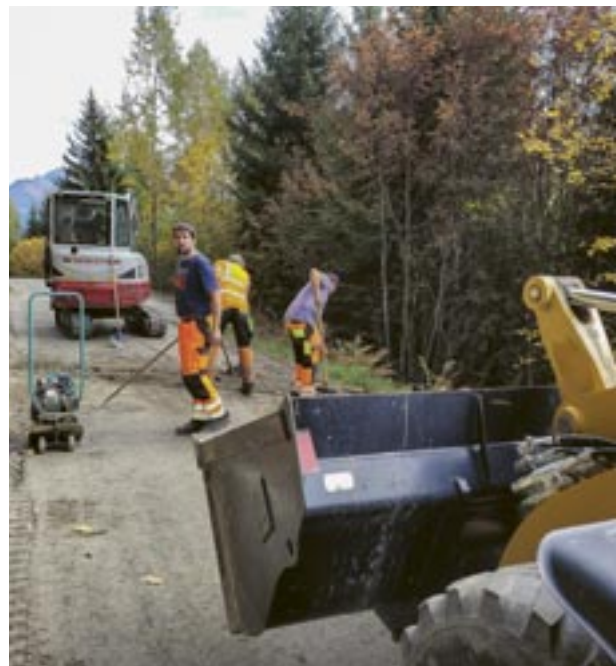
Mitarbeiter des technischen Betriebes beim Einbau der Entwässerungsrinnen.
