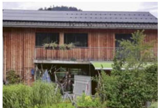
Bedachung und Sonnenkollektoren verschmelzen zu einer Einheit.
