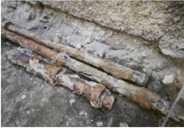
Die alten Gusseisenleitungen an der Via S. Clau in Rueun wurden freigelegt und durch neue ersetzt.
