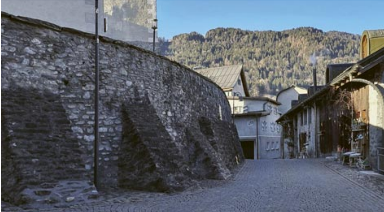
Auf Kopfsteinplaster gelangt man durch das Rote Tor nach Fussau, dem ehemaligen Stadtgraben.
