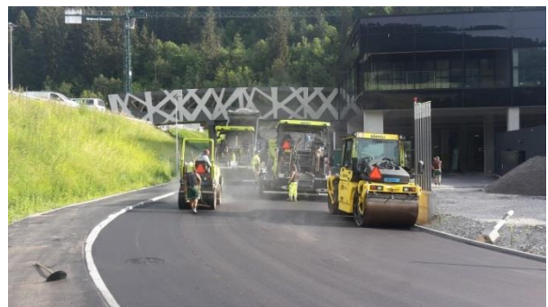
Lavurs da cuvrada per la via nova Crappa Grossa, Glion.
